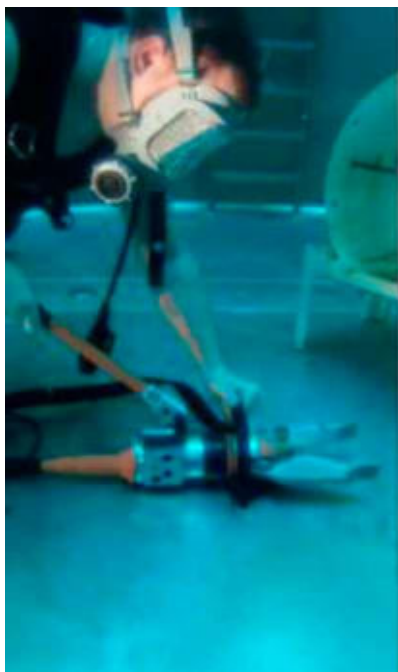
Рис. 4.6. Перекусывание арматуры при помощи РКГм 63.
